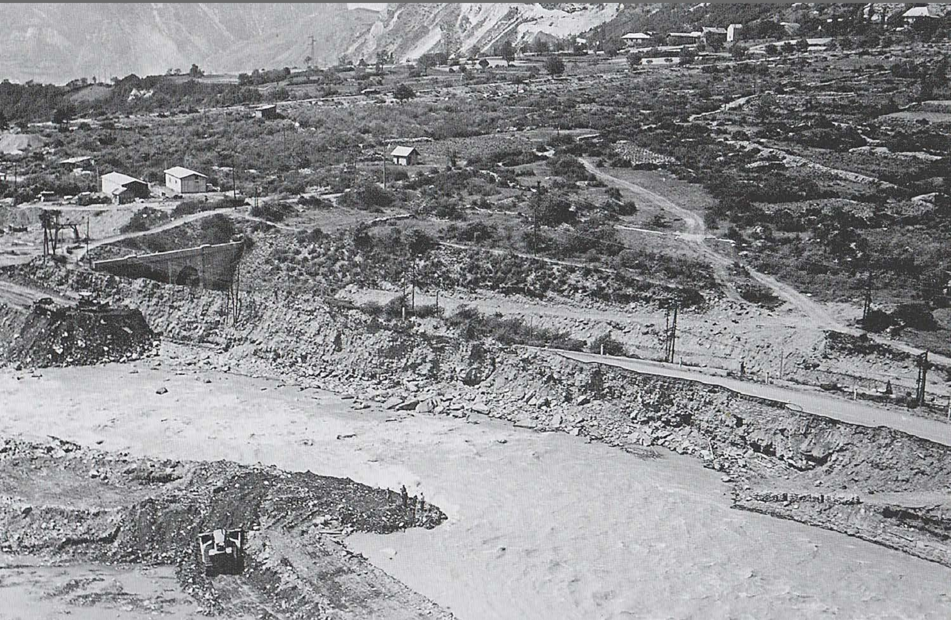
Route nationale 6 détruite en amont de Saint-Julien
